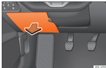
Sl. 55 Na voznikovi strani armaturne plošče: pokrov postaje z varovalkami.
